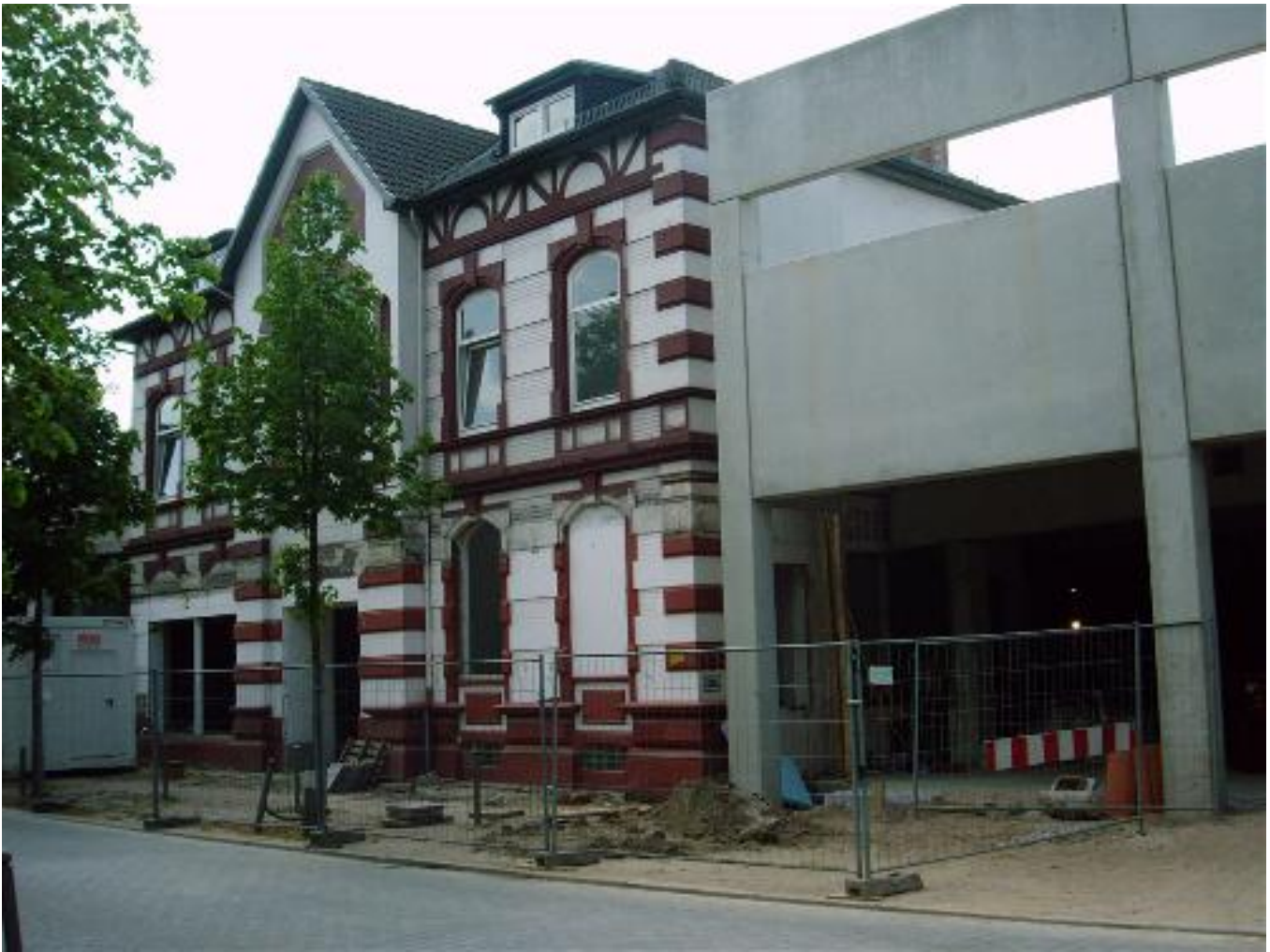
Das alte Ballhaus als Bestandteil des im Bau befindlichen Lindenhof-Centers
